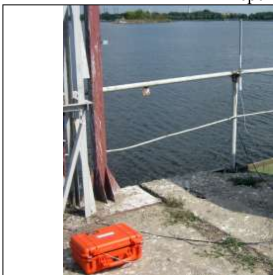
Контейнер с мобильным береговым модулем и антенна беспроводной связи
