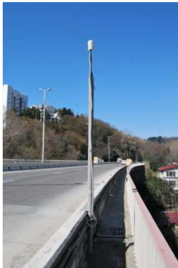
Размещение смарт-антенны на эстакаде
