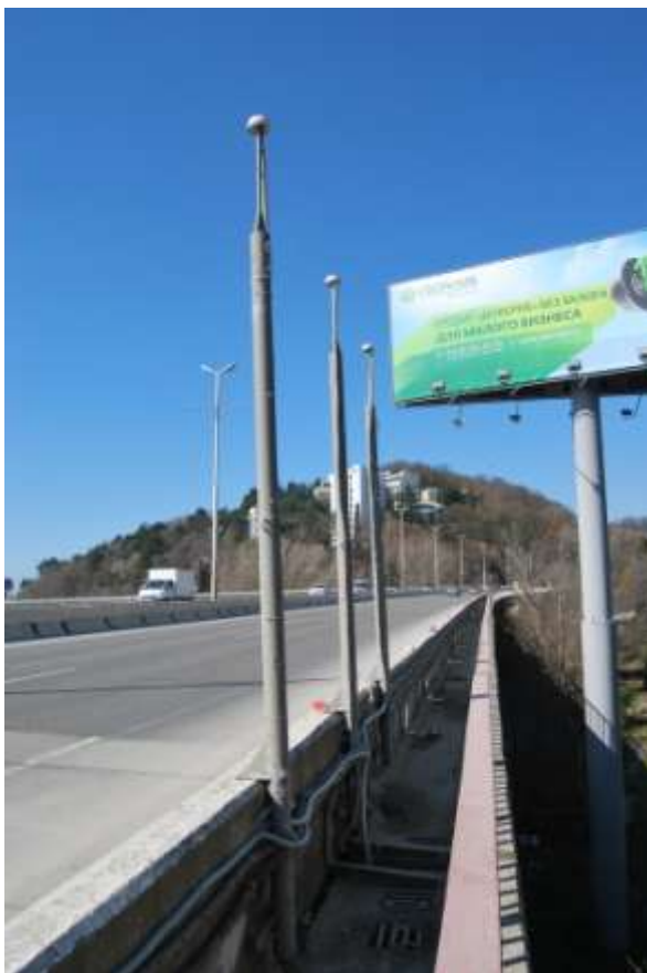
Размещение стандартных антенн на эстакаде
