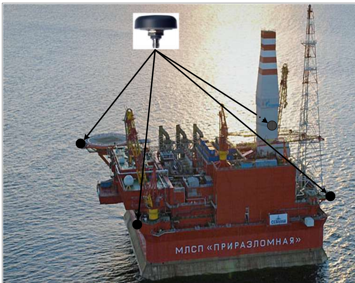
Рисунок 12 – Расположение двухчастотных спутниковых антенн системы измерения деформаций морского сооружения
